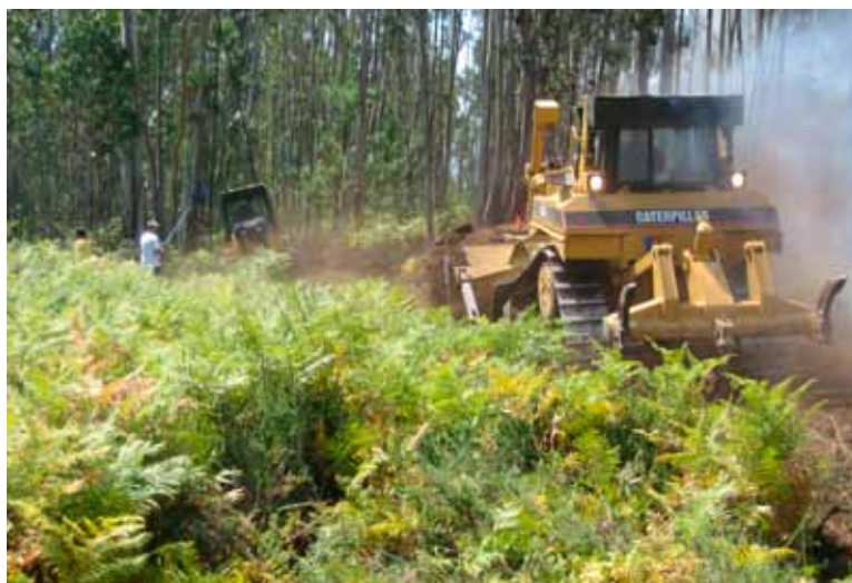
Imagen de un Bulldozer D-8.(Fuente: José Luis Duce)
