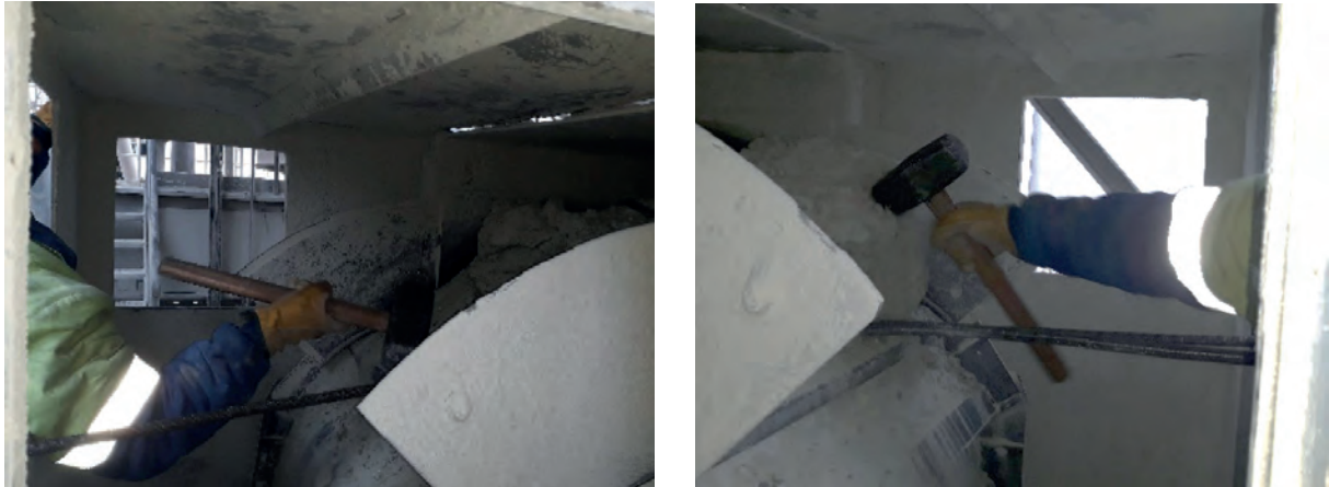
Figura 91. Agarre inadecuado del mazo.
