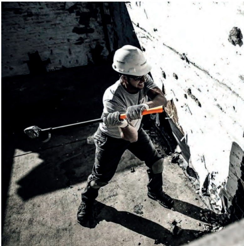
Figura 99. Empleo de mazo grande de demolición (Fuente: Fiskars).
