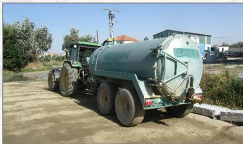
Ejemplo: Regado de zonas de trabajo para evitar la propagación de polvo
