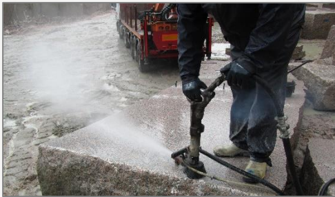
Ejemplo: Nebulización del polvo en la fuente con agua y aire comprimido
