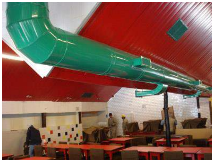
Sistema de ventilación general
