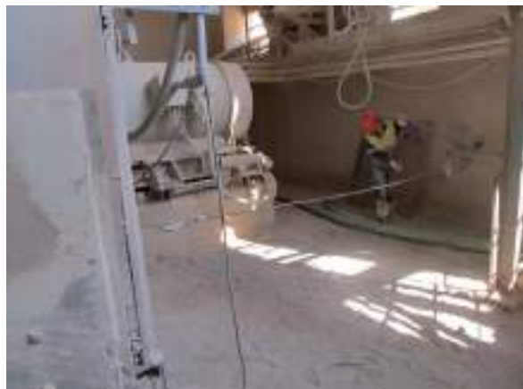
Figura 3.9. Utilización de polipasto para la extracción del eje de la trituradora.
