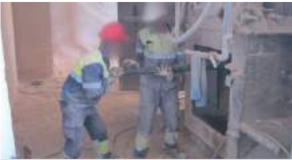
Figura 4.2.10. Colocación de nuevos ejes en la trituradora.
