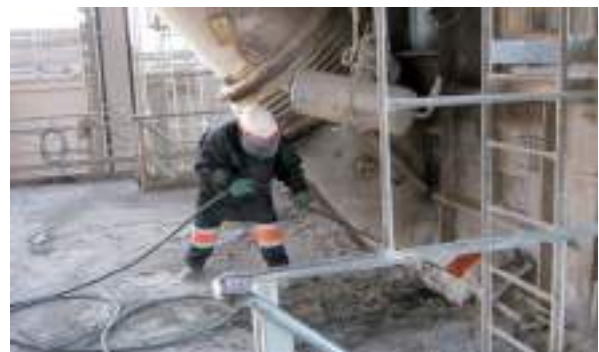
Figura 3.18. Operaciones de limpieza de ciclones con acumulación de material en la superficie de trabajo.
