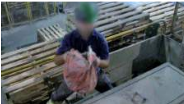
Figura 4.4.10. Levantamiento de sacos de cemento rotos.
