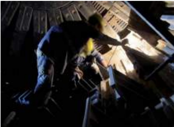
Figura 4.3.22. Iluminación del interior del molino.
