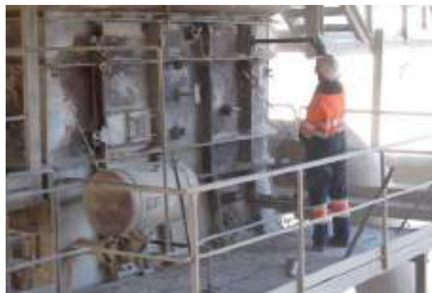
Figura 4.5.2. Izquierda: limpieza de los ciclones mediante lanza. Derecha: instalación del sistema CARDOX.
