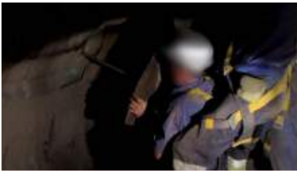
Figura 4.3.7. Colocación de la placa en la pared interior del molino.
