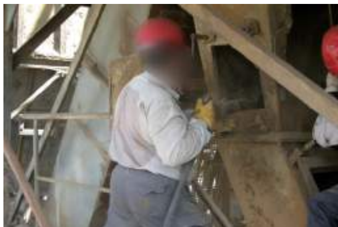
Figura 4.1.14. Utilización del martillo neumático para la eliminación de pegaduras.
