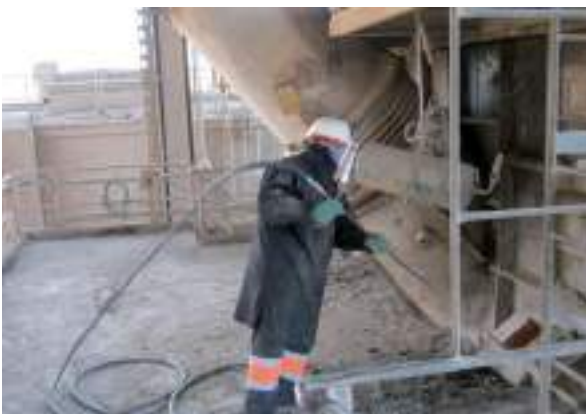
Figura 4.5.2. Izquierda: limpieza de los ciclones mediante lanza. Derecha: instalación del sistema CARDOX.
