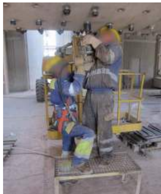
Figura 4.3.29. Manejo de pistola neumática mediante dos trabajadores.
