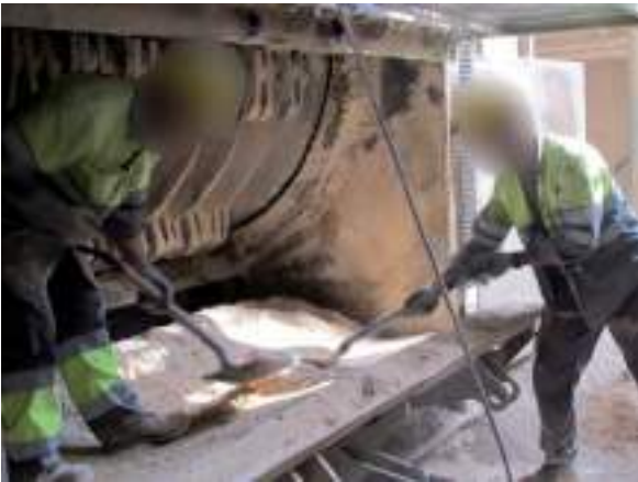
Figura 3.3. Trabajos de limpieza de la zona de trabajo.
