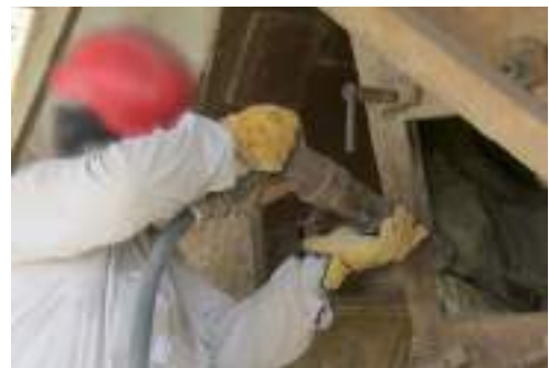
Figura 3.14. Herramientas utilizadas para el desatranque de tolvas.
