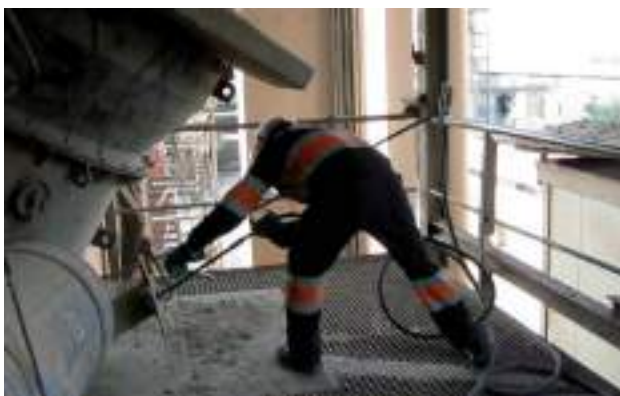
Figura 4.5.14. Flexión de espalda durante la limpieza de ciclones con lanza.
