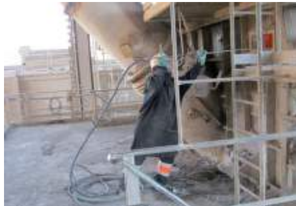
Figura 4.5.1. Tareas de limpieza en ciclones.
