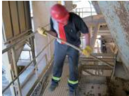
Figura 3.12. Aplicación de fuerzas intensas en el desatranque de tolvas.
