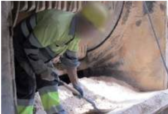
Figura 4.2.4. Extracción mediante pala del material situado en el interior de la trituradora.
