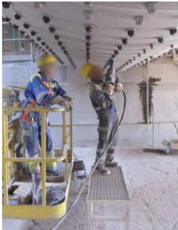
Figura 4.3.3. Desatornillado de placas en la parte exterior del molino.
