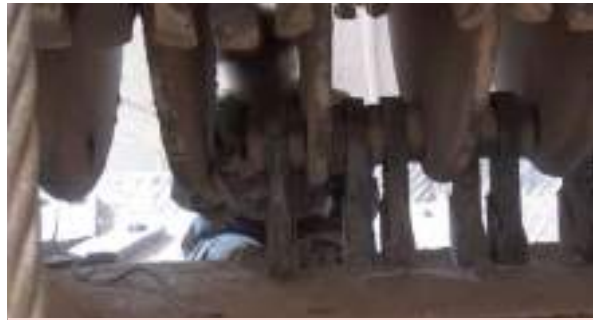
Figura 4.2.11. Colocación de martillos nuevos en la trituradora.
