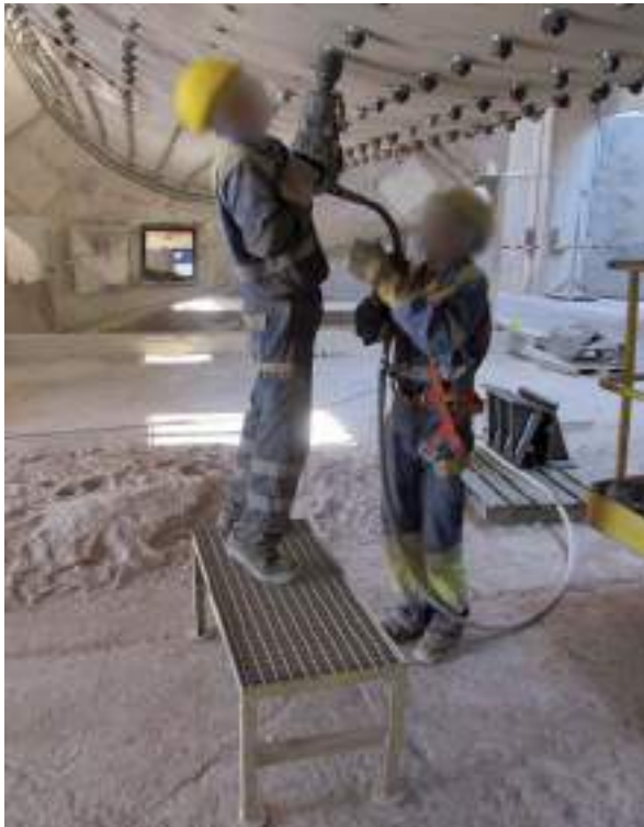
Figura 4.3.19. Utilización de pistola neumática para el apriete de la tuerca de la placa en la parte exterior del molino.
