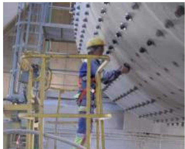
Figura 4.3.26. Plataforma elevadora en la tarea de atornillado exterior de las placas.
