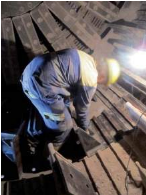
Figura 4.3.14. Colocación de placas nuevas en el interior del molino.
