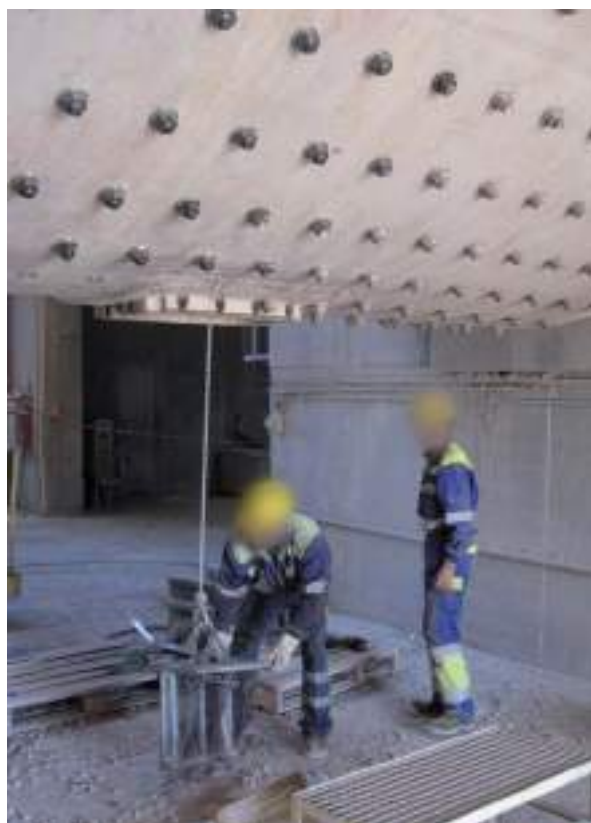
Figura 4.3.4. Inserción de placas nuevas en el molino.
