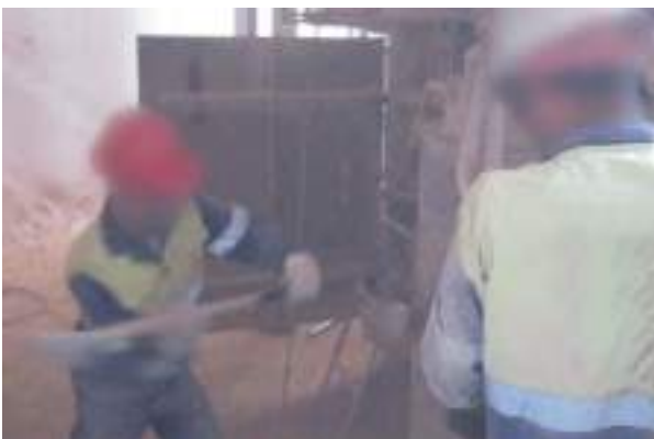
Figura 4.2.27. Golpeo del eje nuevo en la trituradora.
