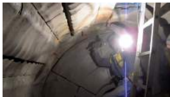
Figura 4.3.18. Aplicación de fuerzas con el martillo en el cambio de placas en el molino.
