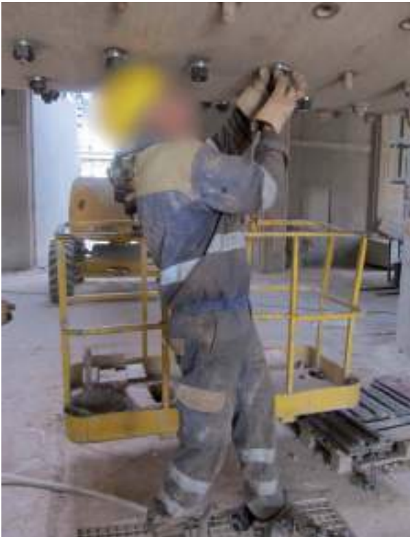
Figura 4.3.10. Colocación de las tuercas en la placa en la parte exterior del molino de bolas.
