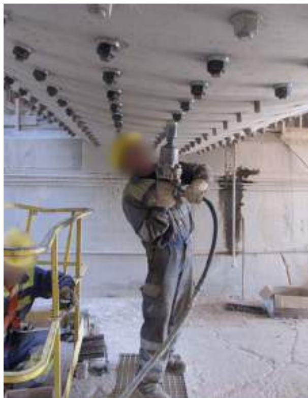
Figura 4.3.10. Colocación de las tuercas en la placa en la parte exterior del molino de bolas.
