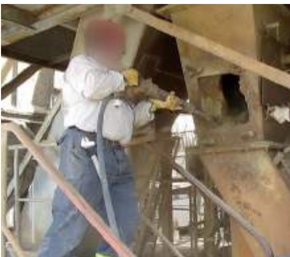
Figura 4.1.6. Desatranque de tolvas mediante martillo neumático.
