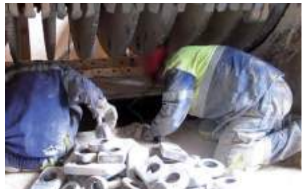
Figura 4.2.7. Retiro de los martillos y distanciadores desgastados en la trituradora.
