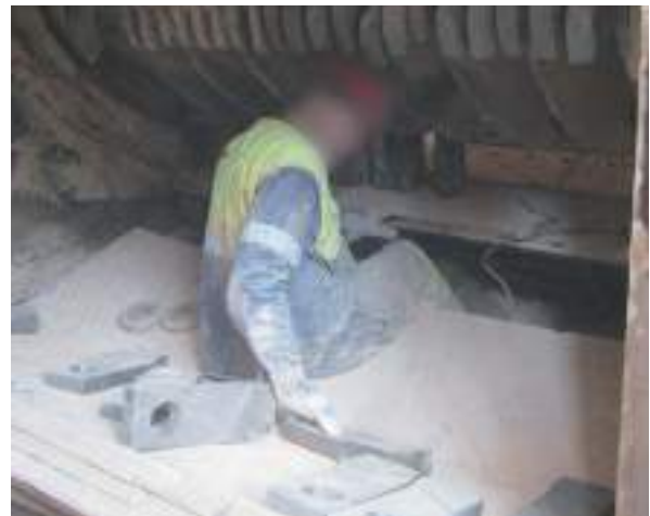
Figura 4.2.14. Giro de tronco durante la colocación de martillos nuevos en la trituradora.
