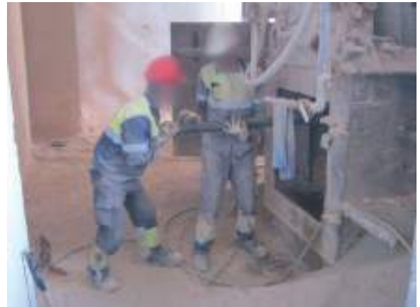
Figura 4.2.23. Inserción del eje en la trituradora.
