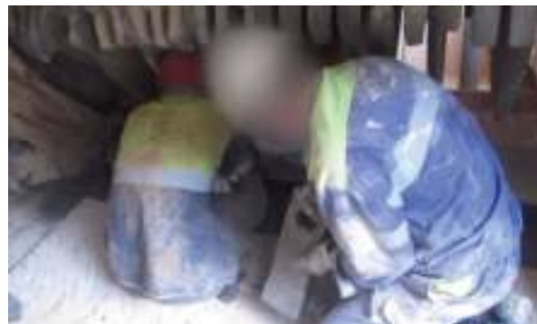
Figura 4.2.38. Suministro de los nuevos martillos en la trituradora por parte de un trabajador.
