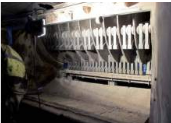
Figura 4.2.2. Eje de martillos en el interior de la trituradora.
