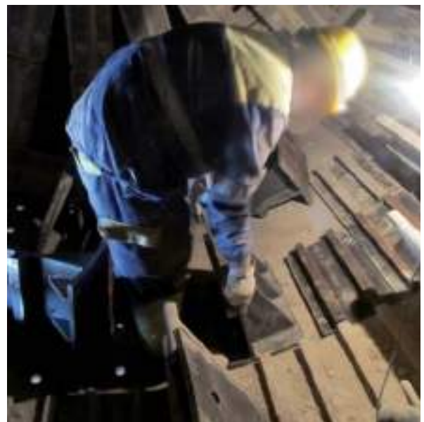
Figura 4.3.9. Colocación de los tornillos en la placa en el interior del molino.
