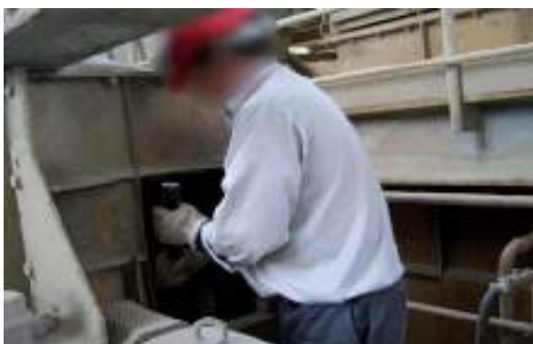
Figura 4.1.3. Tarea de desobstrucción en las tolvas de transferencia entre transportadores.
