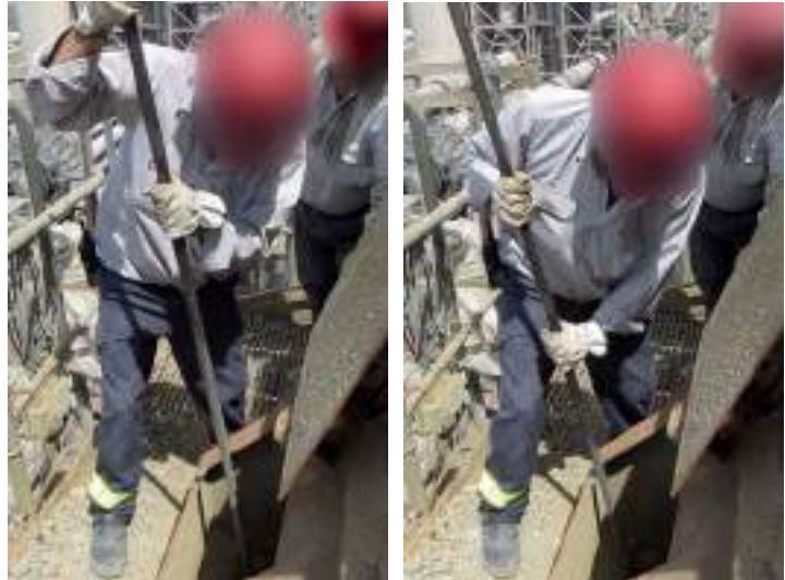
Figura 3.13. Desatranque de tolvas mediante el golpeo de barra.
