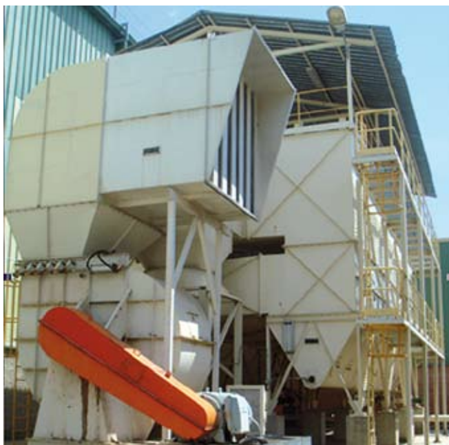
Sistema de aspiración y depuración de aire en fábrica de tableros de fibras/partículas.
