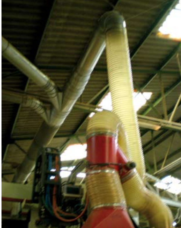
Taladro de control numérico. Detalle del dispositivo de extracción localizada, conducto y red de aspiración.
