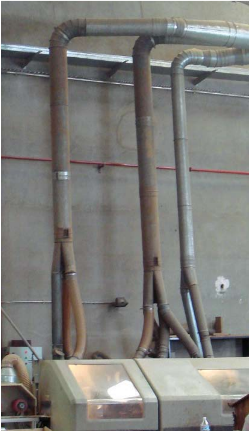
Moldurera. Detalle conductos de aspiración.
