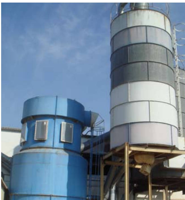
Sistema de aspiración y depuración de aire. Ciclofiltro.
