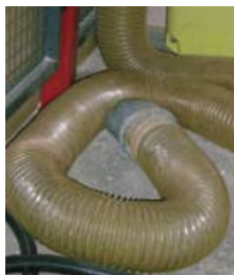
Bocas de aspiración.
