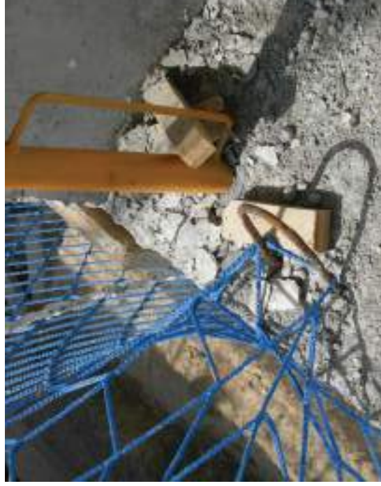
Montante incorporado al forjado
