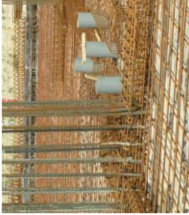
Ferralla montada para el hormigonado de la losa del forjado.
