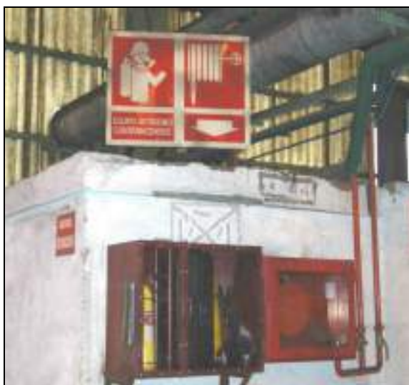
Medios de lucha contra incendios señalizados
