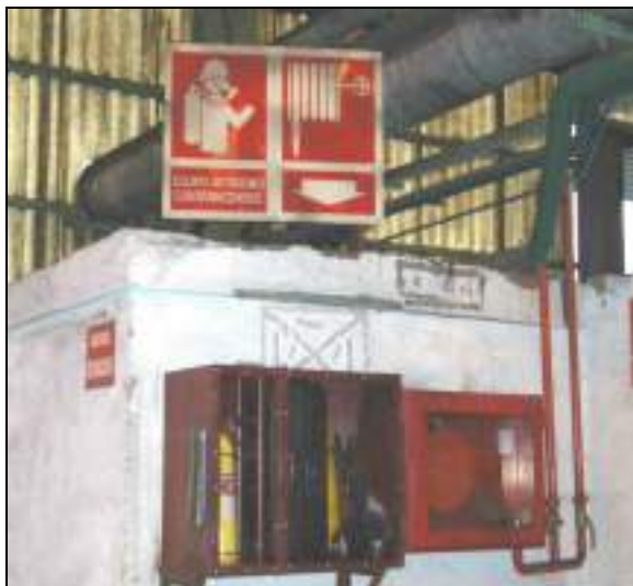
Medios de lucha contra incendios señalizados
