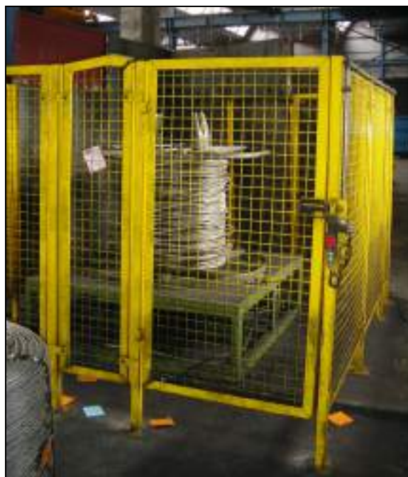
Detalle de un dispositivo de enclavamiento que impide el acceso al carrete mientras está en movimiento.
