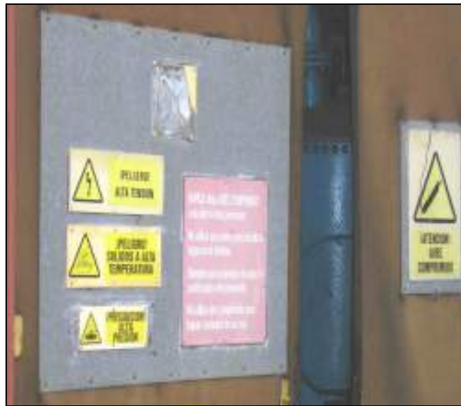
Entrada a la instalación de aire comprimido. Señalización de riesgo eléctrico, entre otros peligros
