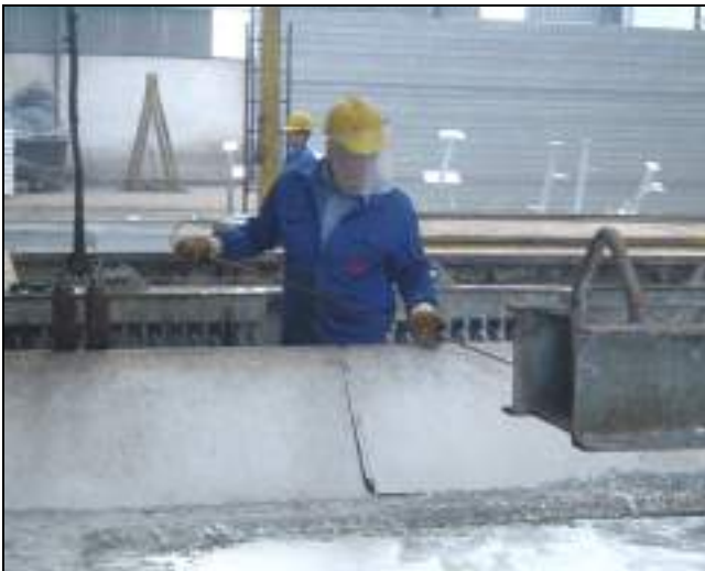
Personal realizando limpieza de la superficie del baño de zinc. Equipos de protección individual: pantalla, guantes contra riesgos mecánicos, casco
