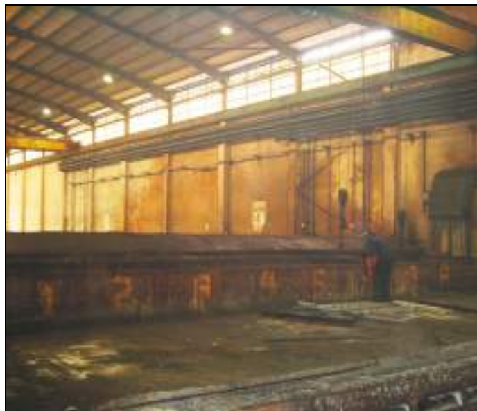
Vista general de una planta de galvanizado, detalle de una cuba
