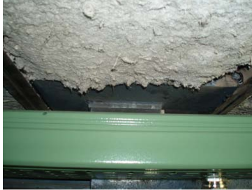
Figura 5: presunto MCA en un techo. El revestimiento presenta una textura típica de MCA. Incluso son perceptibles las fibras a simple vista
